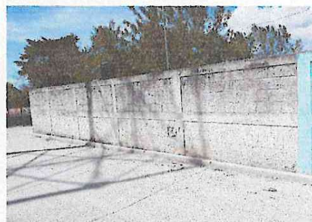
Foto 2: Pintura en muros perimetrales 400 mts cuadrados.
