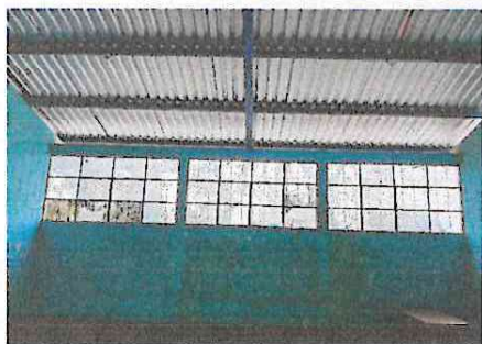
Foto 3: Sustitución de vidrios, por quebraduras.
