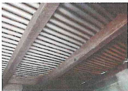
Foto 7: Sustitución de lámina por lámina troquelada por ahujeros
