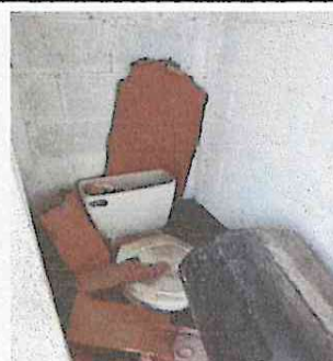
Foto 10: Sustitución de inodoros, por deterioro.
