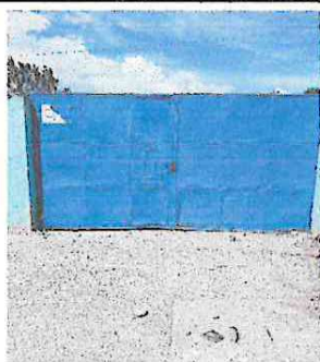
Foto 1: Mantenimiento a portón de metal, sustitución de lámina inferior por picaduras, cambio de visagras, cambio de chapas lijado y pintura.
