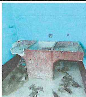
Foto 11: Sustitución de pila por mal estado.
