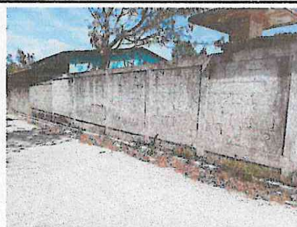
Foto 6: Reparación de muro perimetral de bloques relleno en los ahujeros.
