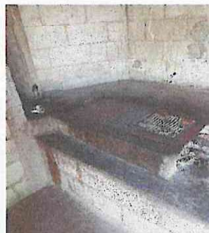
Foto 8: Sustitución de plancha de 3 hornillas
