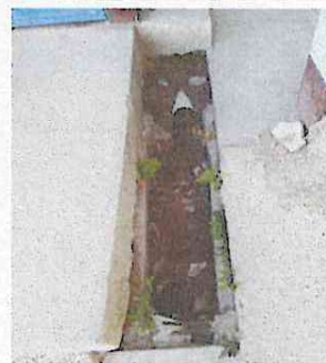
Foto 4: Sustitución de tubería PVC línea principal aguas pluviales de medida de 10 pulgadas.
